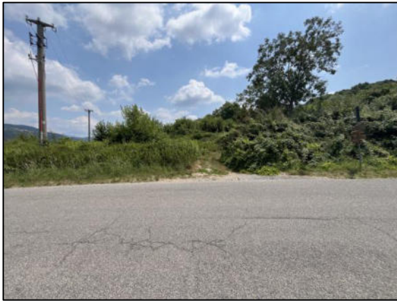
FOTO 1: INIZIO STRADA LOC. CEREGALLO
