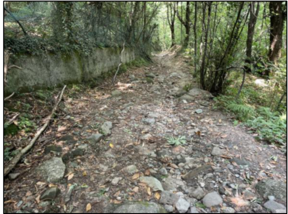
FOTO 4: EROSIONE CARREGGIATA
