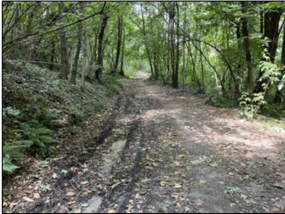
FOTO 3: EROSIONE CARREGGIATA
